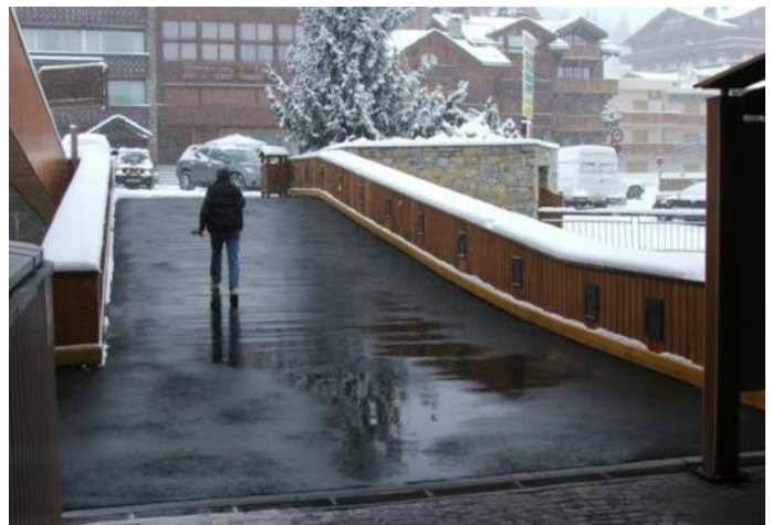
Beheizte Fußgängerbrücke bei Schneefall: Sicherheit für die Nutzer
