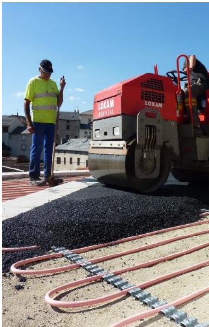
Einbau einer MB-Freiflächenheizung
