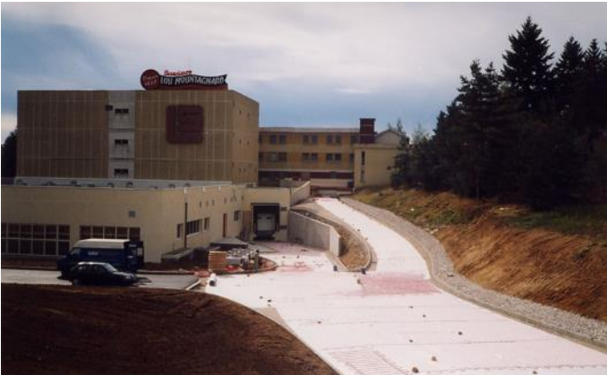
Rue privée du saloir « Les Montagnards » à Saint-Maurice de Lignon/France, pose réalisée en 1999 par le partenaire MB SABY, ce système récupère la chaleur issue du réfrigérateur du saloir
