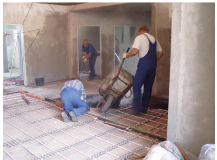
Sanitaires du camping Gross Quassow, 2005, pose réalisée par l'entreprise Reinhard Schneider de Neubrandenburg, Allemagne
