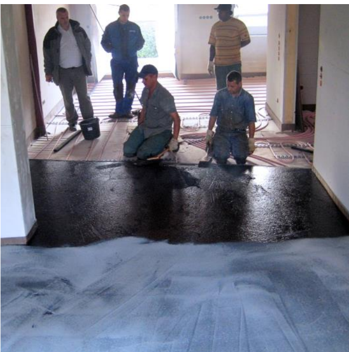
EFH in Oberursel 2007, verlegt durch Fa. Pfeiffer aus Bad Vilbel
