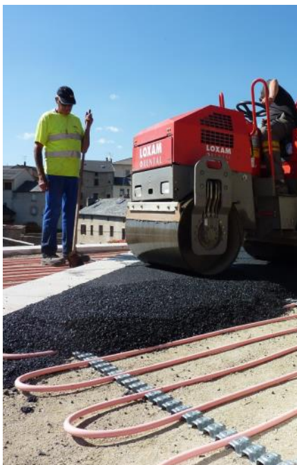
Installation d'un chauffage de surface en extérieur MB
