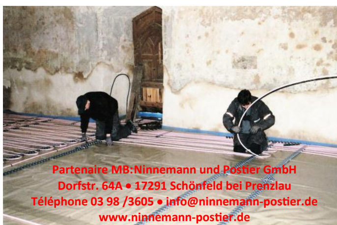
Pose du chauffage au sol MULTIBETON
